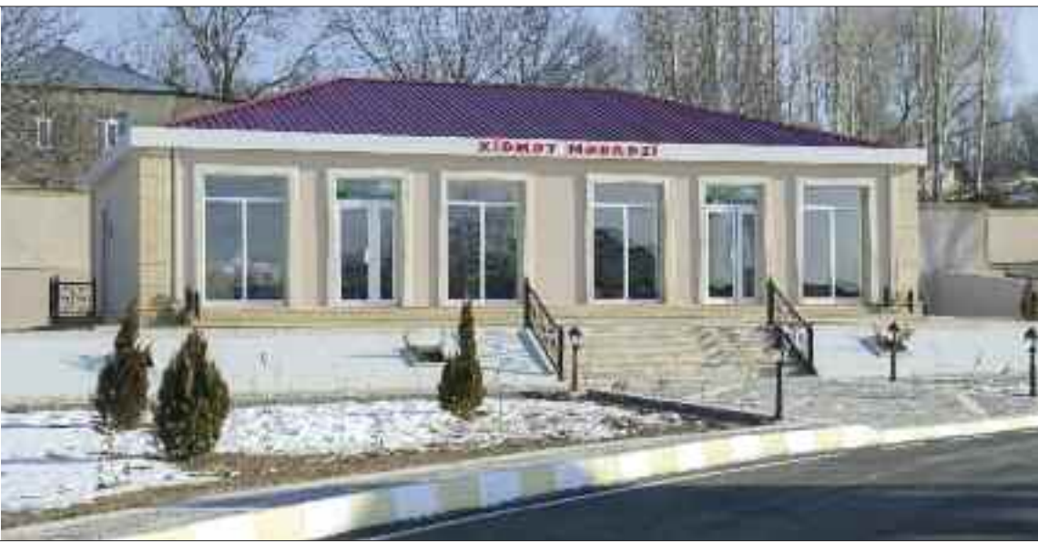
Kəngərli rayonunun Yurdçu kəndində xidmət mərkəzi
