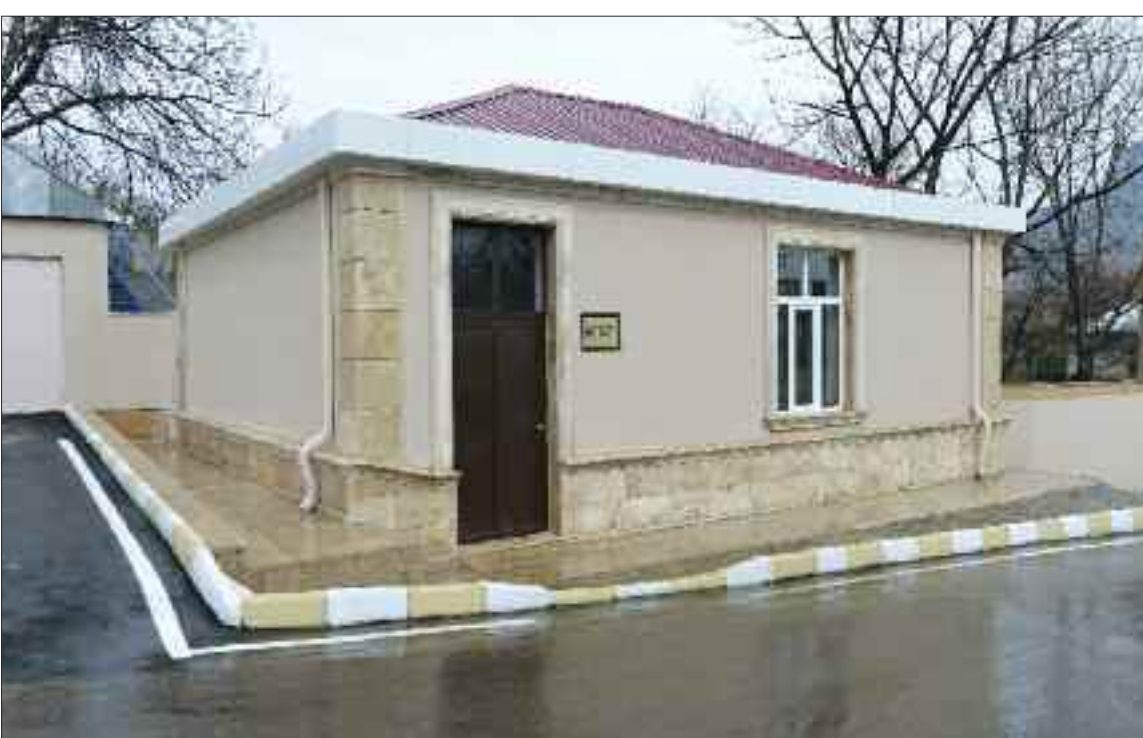
Culfa rayonunun Saltaq kəndində su dəyirmanı
