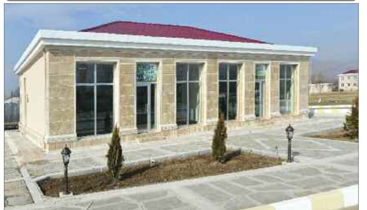
Şərur rayonunun Oğlanqala kəndində xidmət mərkəzi
